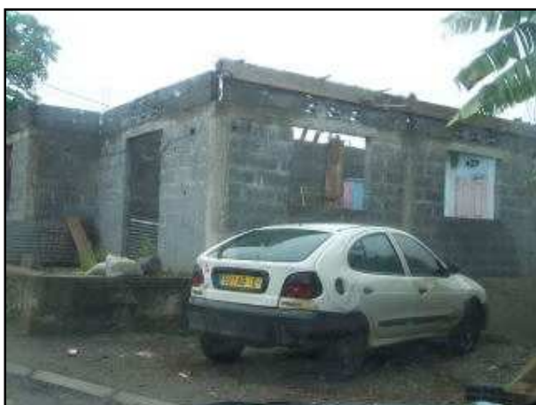
Doc. 26 et 27 – A gauche, une maison en parpaing en construction. A droite, une ancienne case SIM en brique dans le village de Nyambadao. Crédit photographique - BET TEMA, 2008.
