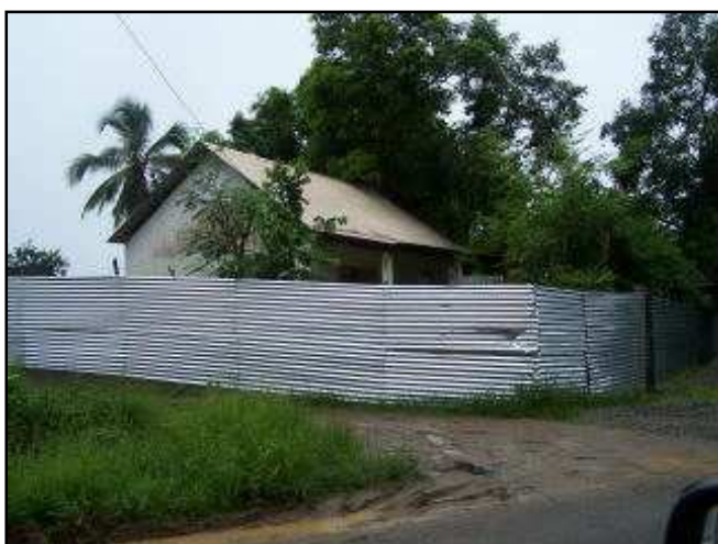
Doc. 28 – Généralisation des clôtures en tôles sur la commune de Bnadré comme ici à Mounyambani. Crédit photographique - BET TEMA, 2008.
