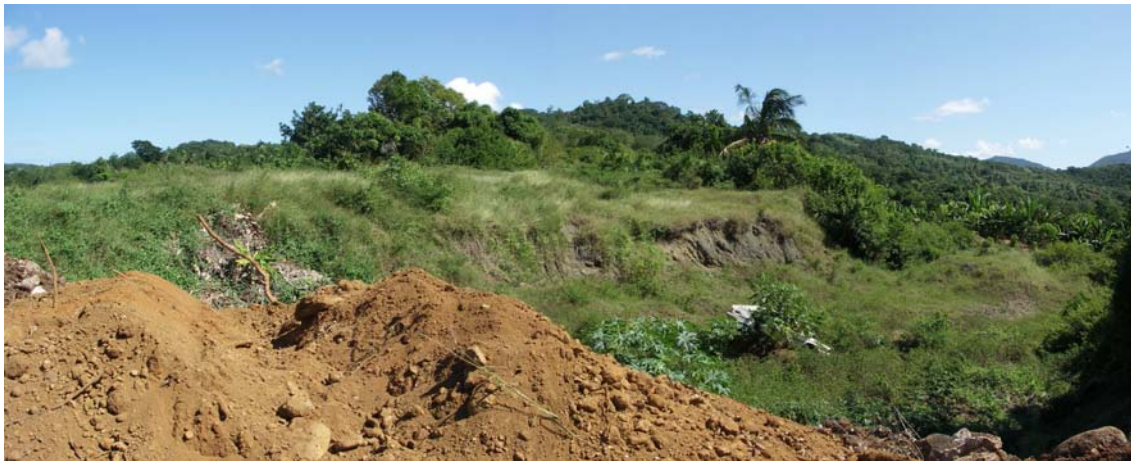
Doc. 31 – Vue du site d'emprunt en cours de remblaiement. Crédit photographique - ESPACES, 2008.
