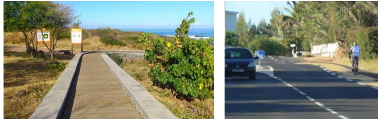
Accès PMR du littoral de Trois Bassins et une RNIA aménagée pour les vélos
