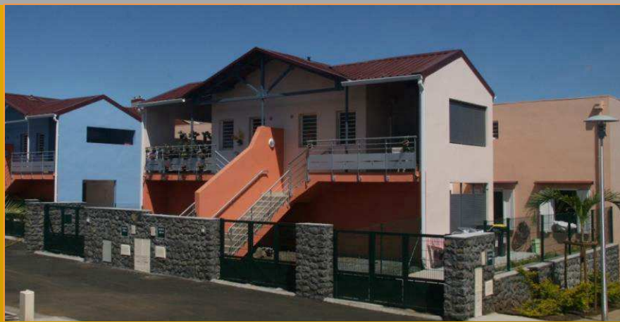
Maison de ville à Trois Mares
