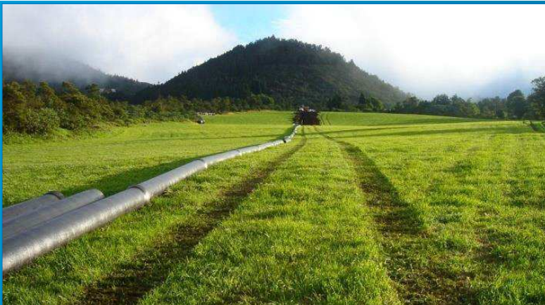
Travaux d'irrigation à Piton Hyacinthe
