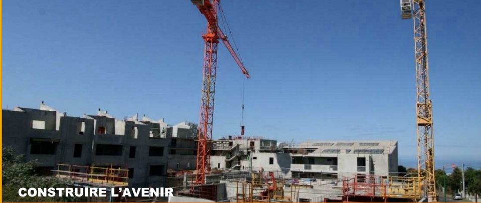
Logements en chantier
