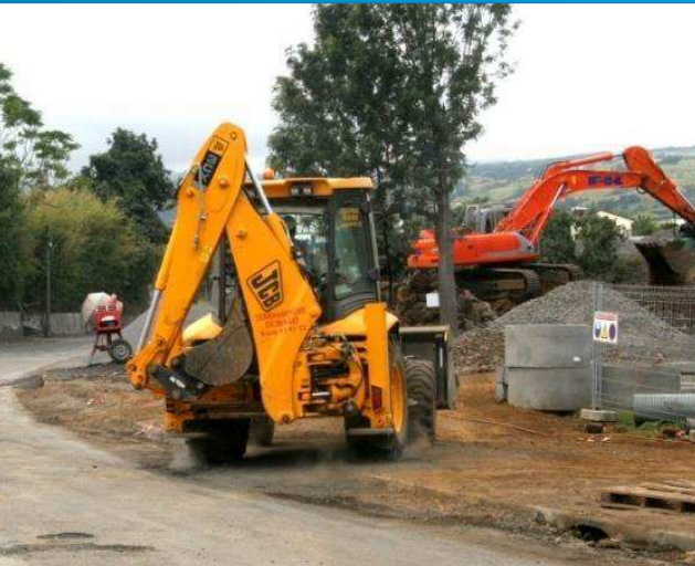
Travaux d'assainissement au 10 e km
