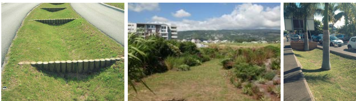
Illustrations exemples de voie structurante centre-ville/ déviation/noues/ fossés drainants (Métropole/ Zac Beauséjour Ste Marie/ Ravine Blanche St Pierre)
