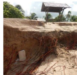
Talus d'érosion de 70 cm, novembre 2020
