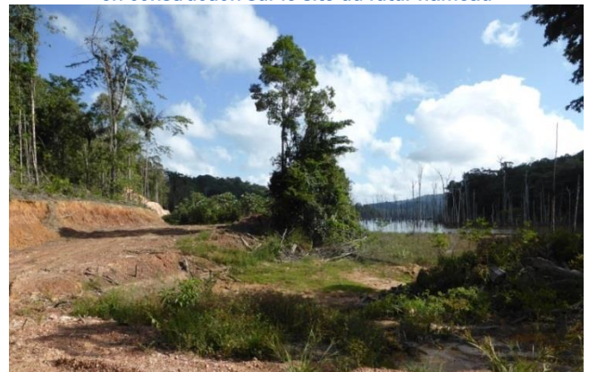
Photo 13 : Vue du paysage lacustre et forestier depuis la route en construction sur le site du futur hameau
