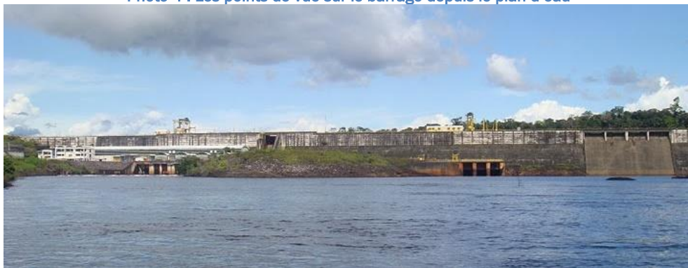
Photo 4 : Les points de vue sur le barrage depuis le plan d'eau
