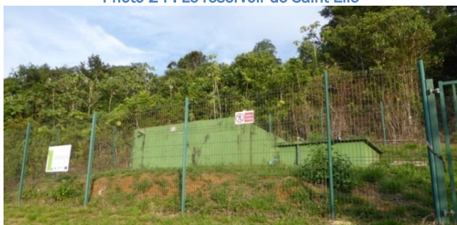
Photo 24 : Le réservoir de Saint-Élie
