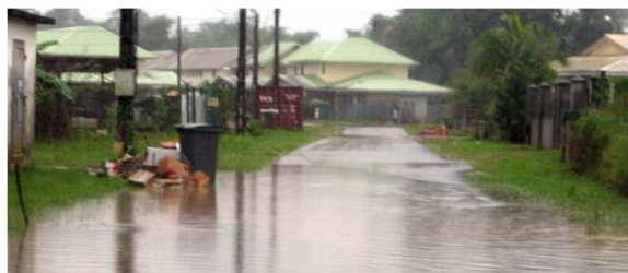
Rue Carême inondée (au niveau de la rue Carafa)
