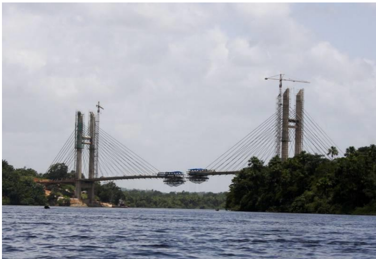
Construction du pont sur l'Oyapock – mai 2011
