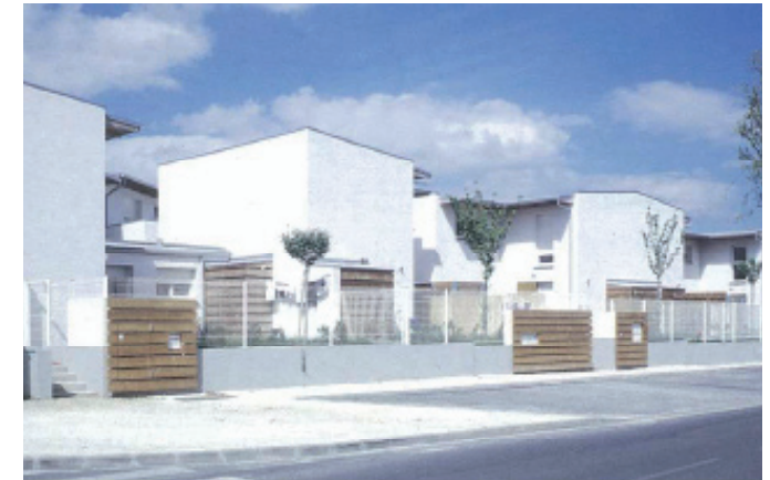
Type de traitement de clôture sur rue: soubassement béton, grillage et lames de bois ajourées
