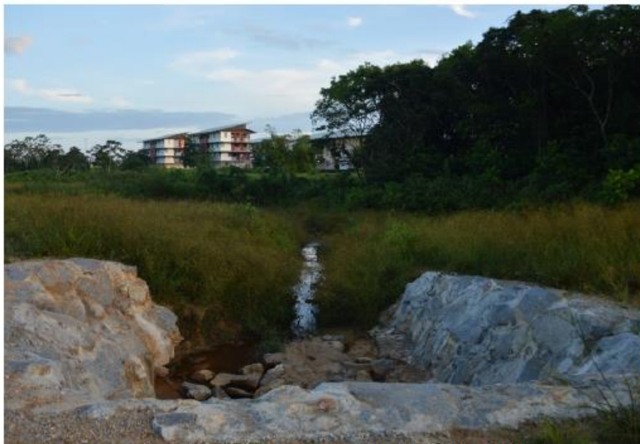
Ouvrage hydraulique nouvellement créé - travaux Autour de la place à Porte de Soula (GTI pour l'EPFAG)
