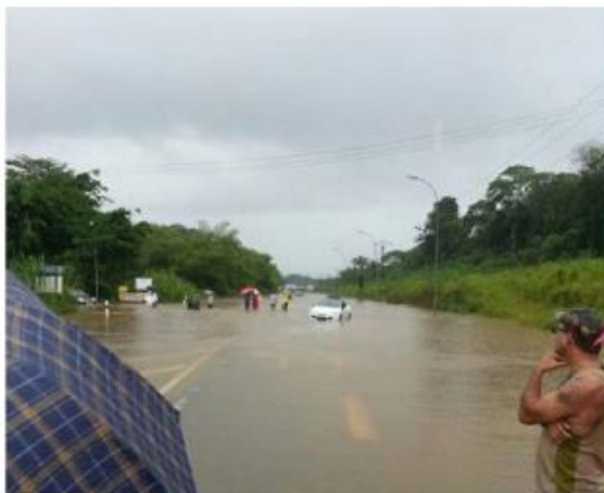
Inondation de la RN1 au droit de Soula 1 le 15 mai 2013 (France Guyane), photo issue de l'étude d'impact AGIR, mars 2018
