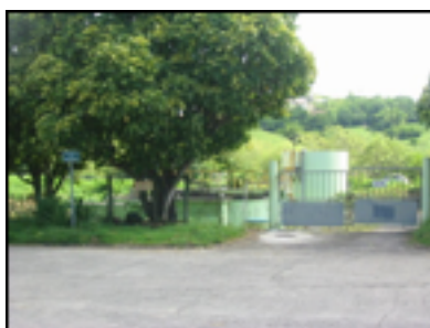
PHOTOGRAPHIES : STATION D'ÉPURATION AU QUARTIER LES CÔTEAUX
