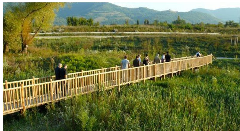
Aménagement d'une zone inondable, Meylan (38). Source : sillon38.com
