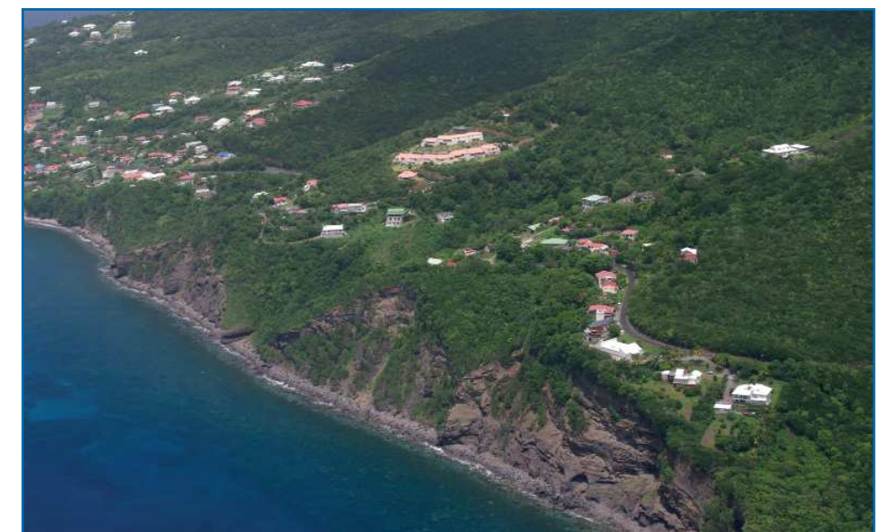
impact visuel relativement fort pour la résidence Beauséjour (crédit : DEAL)
