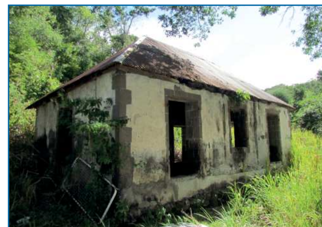
casemate du lieu-dit Le Havre
