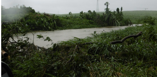
Ravine Grossou au niveau du pont en crue
