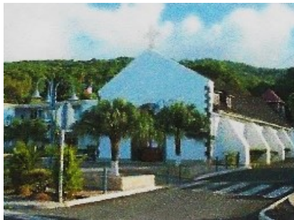
L'ossature en béton est consolidée par un système de contreforts
