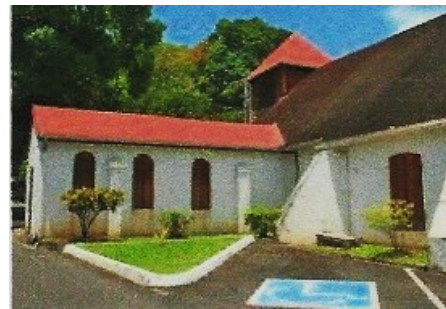
L'ossature en béton est consolidée par un système de contreforts
