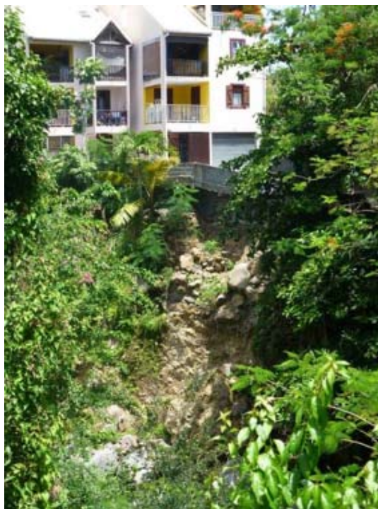
Source : Lavigne (Depuis le pont de la Circonvallation, niveau Versailles) Logements exposés aux risques mouvement de terrain et inondation
