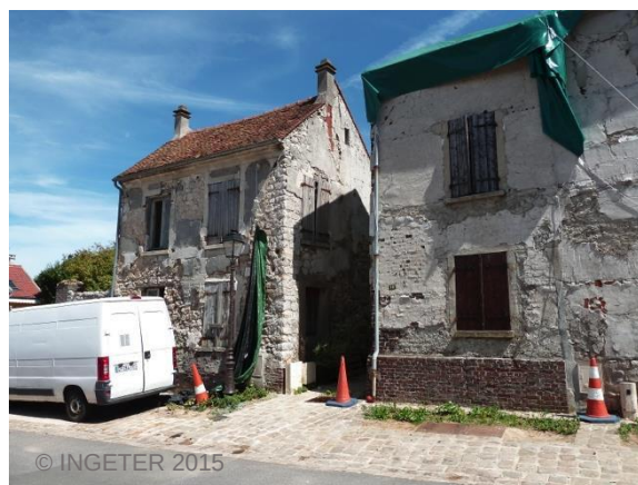
Figure 84 : Habitat ancien, rue Georges Pompidou
