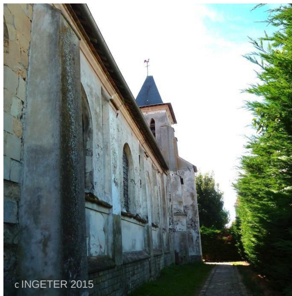
Figure 102 : Façade nord de l'église
