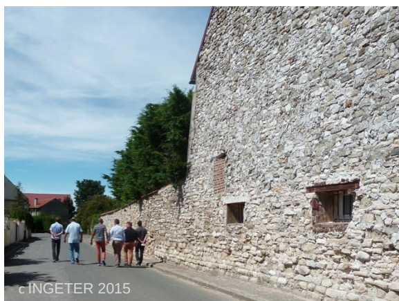
Figure 106 : Dépendance et mur de clôture XVIII ème , rue du Lavoisier.
