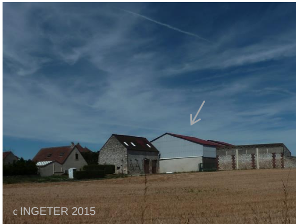
Figure 96 : Bâti agricole, rue du Lavoir
