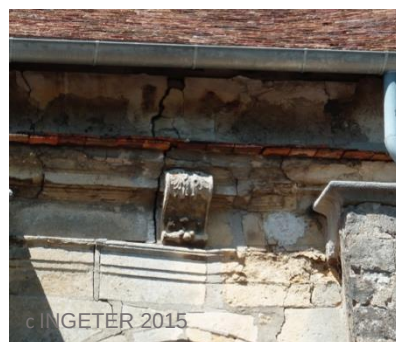
Figure 104 : Détail de la façade sud
