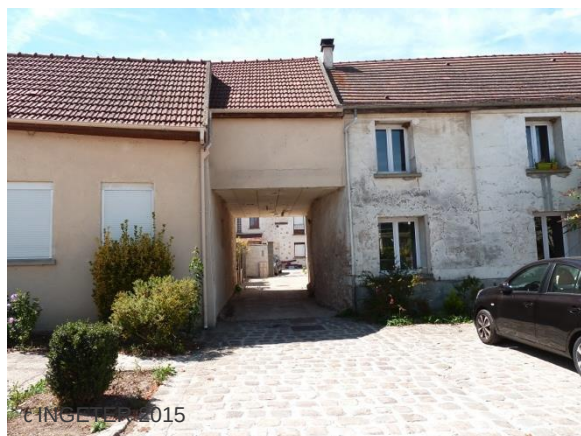
Figure 91 : Petit collectif autour d'un corps de ferme réhabilité, rue Georges Pompidou
