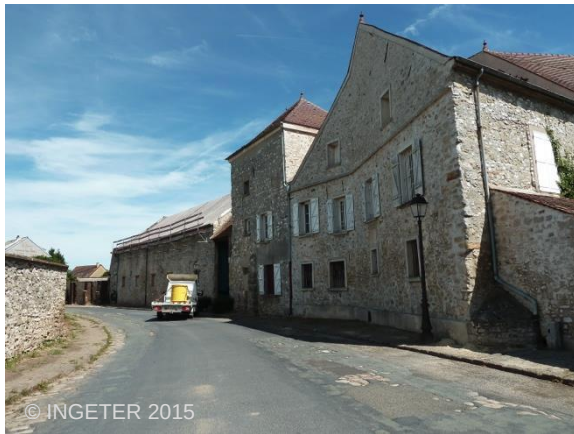
Figure 85 : Ancienne maison forte, rue Georges Pompidou
