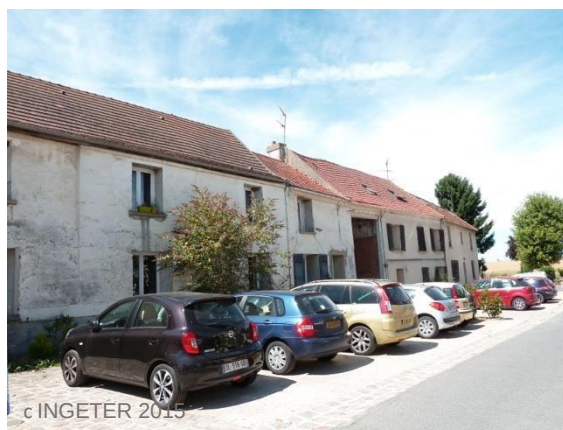
Figure 89 : Ferme réhabilitée en logements collectifs, rue Georges Pompidou
