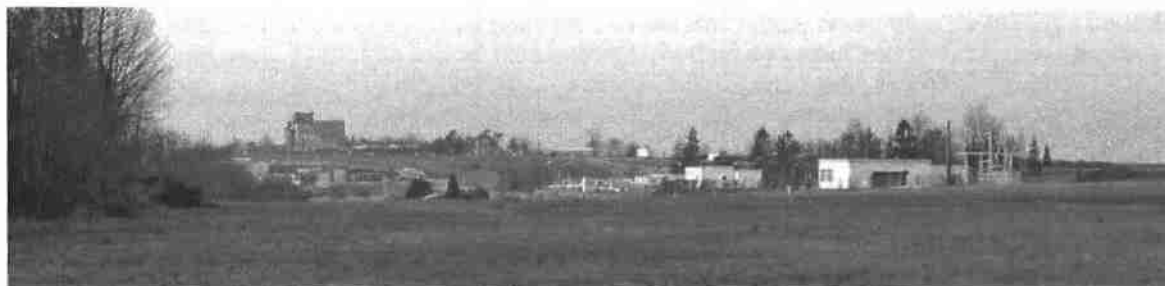
La société Trapil, plateforme d'acheminement du pétrole
