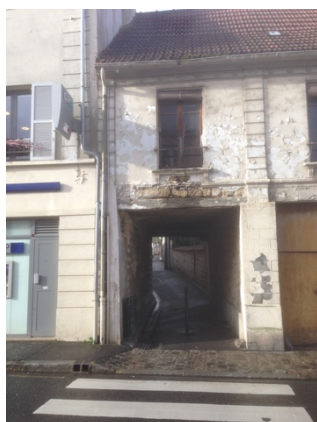
Ruelle du Four
