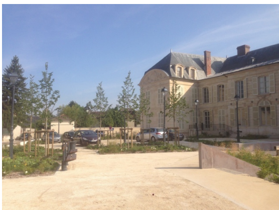
Espaces publics réaménagés (derrière la mairie)
