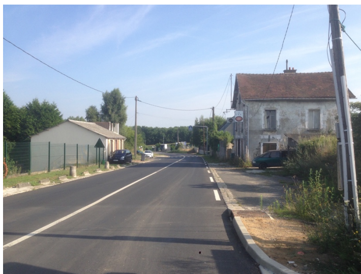
Traversée de la zone de l'Orme (D909z)
