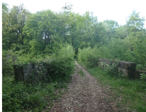
Voie ferrée et pont enjambant la voie
