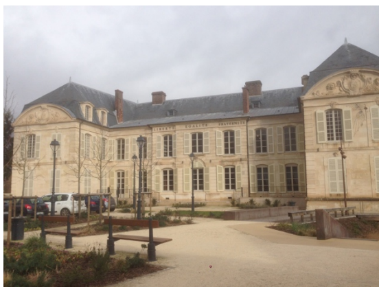
Espaces publics réaménagés (derrière la mairie)
