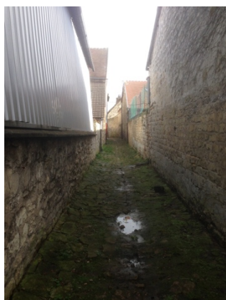
Sente entre la rue de la gare et l'avenue Clemenceau
