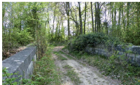
Passage au-dessus de la voie ferrée
