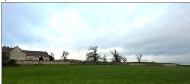
3) Mur de propriété
