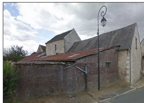
6) L'annexe longeant la rue de Pontoise
