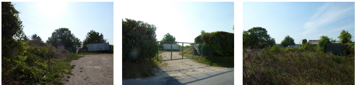
Un terrain actuellement utilisé pour du stockage
