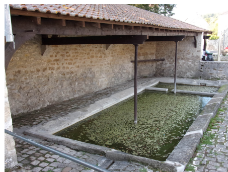
Le lavoir de Saillancourt
