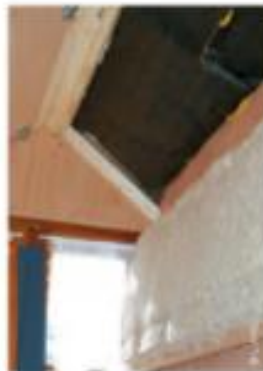
Construction d'un caisson isolé
