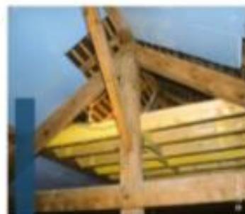
Installation d'un plancher
