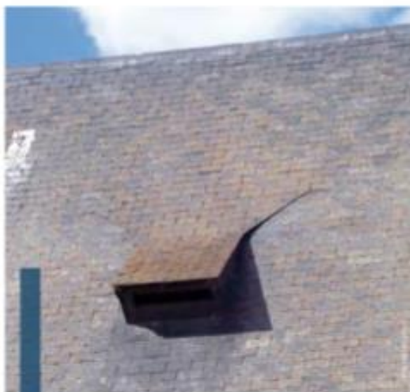
Chiroptière sur le toit d'une église
