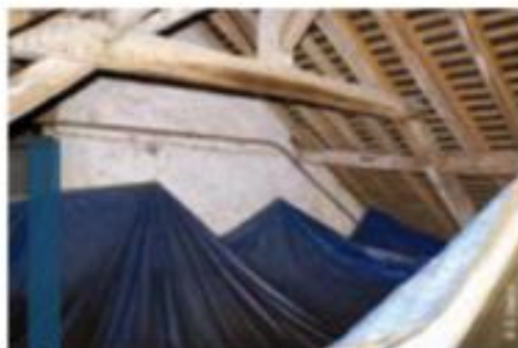
Bâches de protection dans un comble
