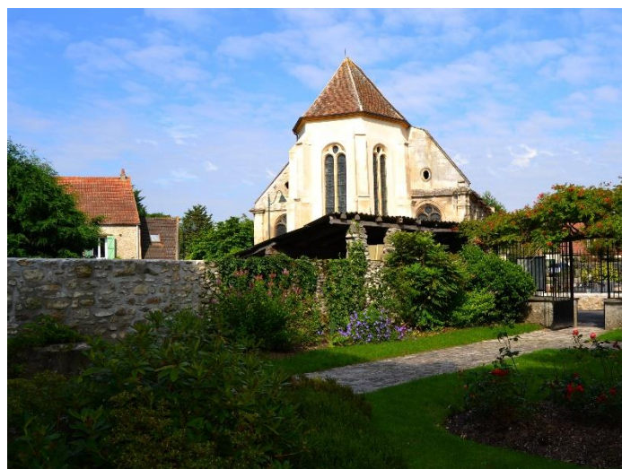
L'église et ses abords rénovés
