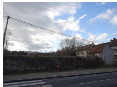
Le mur de soutènement
