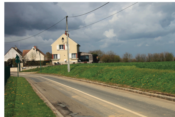
Accès depuis la D159
