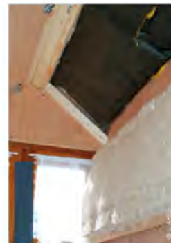
Construction d'un caisson isolé
