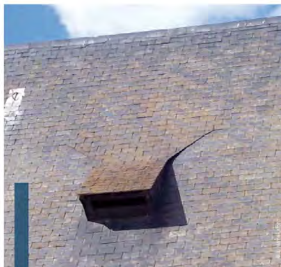
Chiroptière sur le toit d'une église
