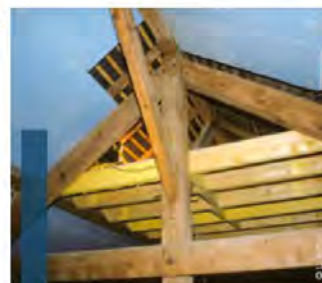
Installation d'un plancher
