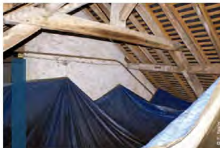
Bâches de protection dans un comble
