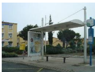
Affiche publicitaire limitée à 2m 2 2 x 2m 2 par 4,5m 2 de surface abritée
