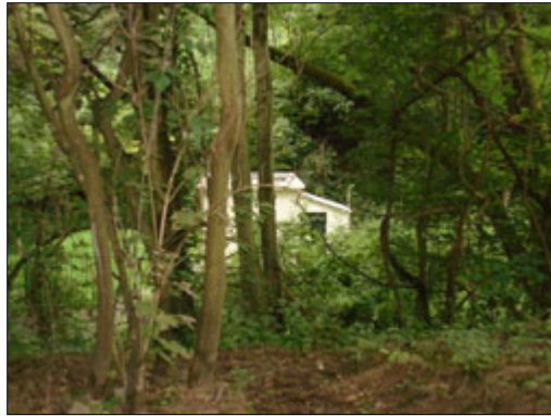
Station de pompage alimentant la commune en eau potable
