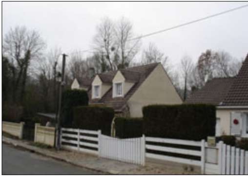
Pavillons récents, rue de la Vallée
