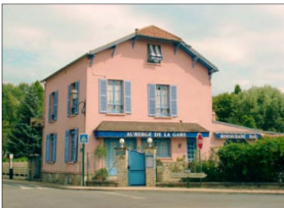
Auberge-restaurant de la Gare
