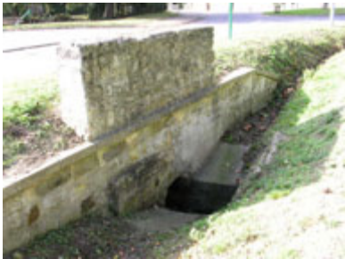
ouvrage au niveau de la RD 92 au dessus de l'affluent Est de la Viosne
