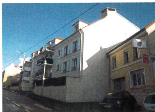
Qualité urbaine rompue par une construction récente
