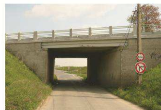
Point de passage délicat pour les engins agricoles situé en entrée de ville
