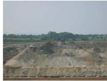
Déchets compactés et enfouis pour favoriser la décomposition et la production de biogaz
