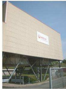
Unité de production d'électricité à partir du biogaz
