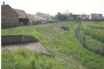
Aval du bassin de rétention et son déversoir
