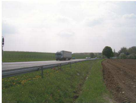
La D316 et la N104, deux axes empruntés par des véhicules susceptibles de transporter des marchandises dangereuses
