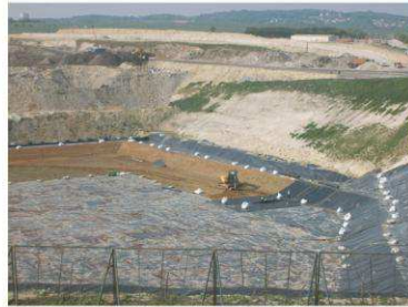
Préparation d'une alvéole de biodégradation des déchets
