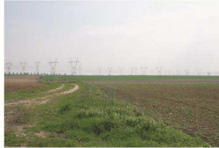
Le Mesnil Aubry est traversé par une ligne électrique à très haute tension
