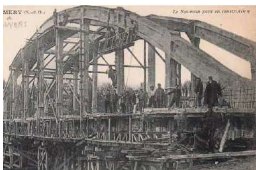
La construction du pont en 1889
