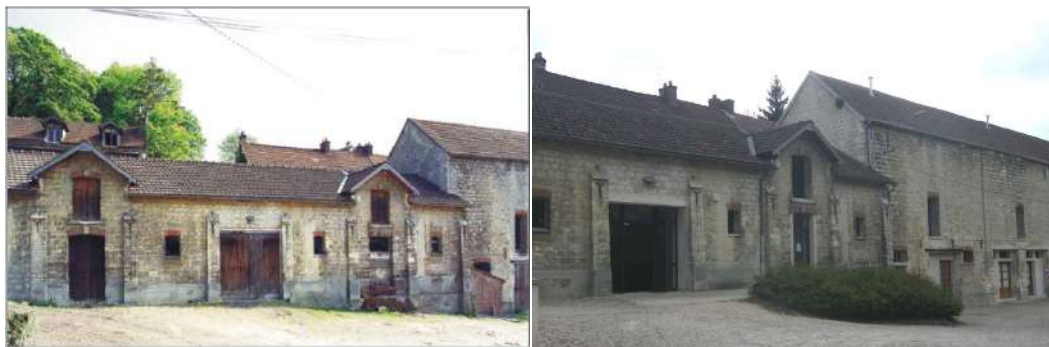
LES ANCIENNES ECURIES DU CHATEAU DE MERY-SUR-OISE-SUR-OISE, AVANT ET APRES LEUR RESTAURATION
