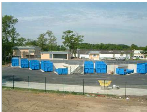
LA DECHETERIE DE BESSANCOURT
