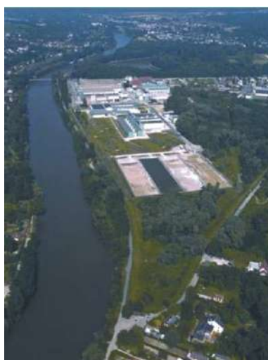
L'USINE DE PRODUCTION D'EAU DE MERY-SUR-OISE
