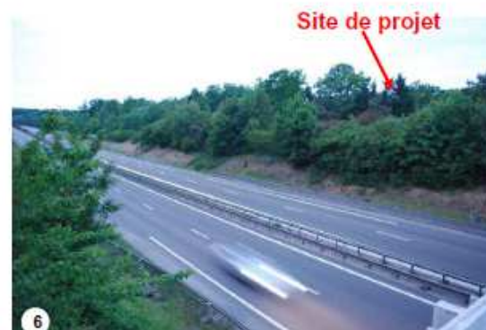
Vue vers le site de projet depuis le pont surplombant la RN 184 Un rideau d'arbres contribue à l'intégration au site.
