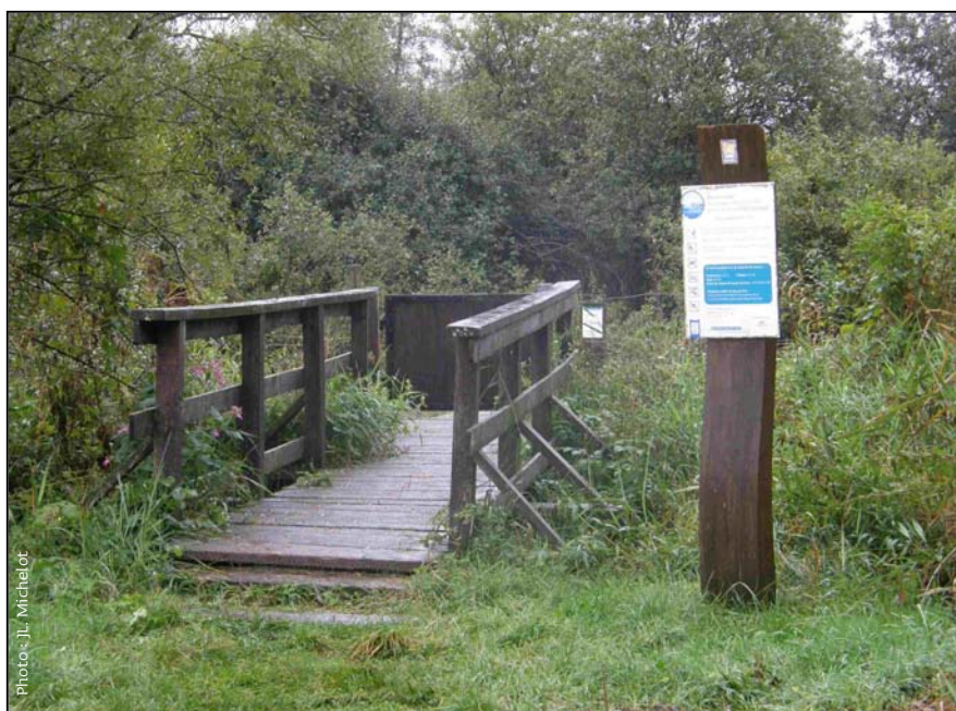
Exemple de passerelle en bois
