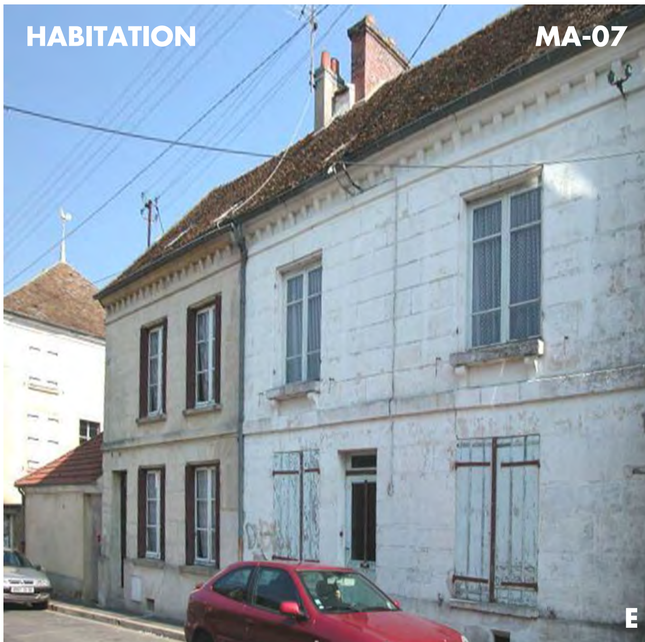
E Vue d'ensemble avant les travaux de rénovation
