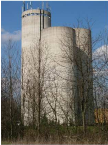
Réservoir d'Osny Marcouville 3000m 3
