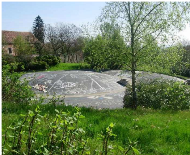
Réservoir de Boisemont 2 x 4000 m 3
