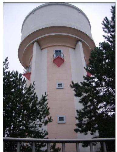
Réservoir de Saint-Ouen-l'Aumône rue du Parc 1000 m 3
