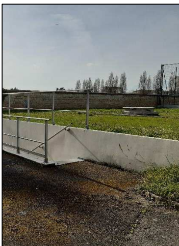
Réservoir de Pontoise rue Claude Debussy 1500 m 3
