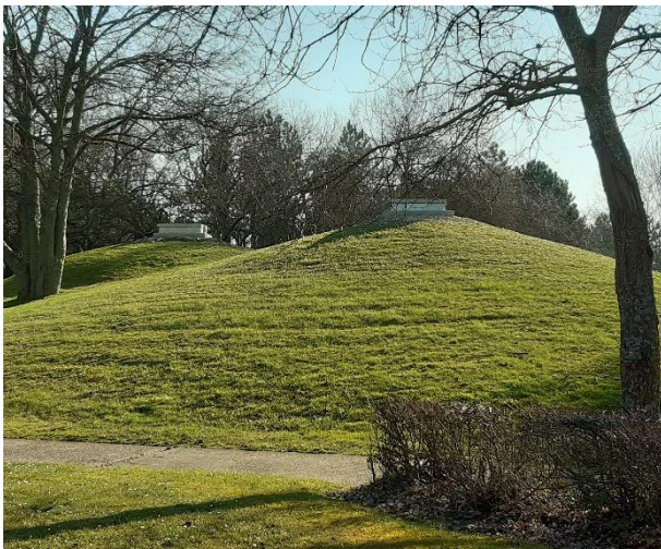
Réservoir de Cergy les Clos Billes
