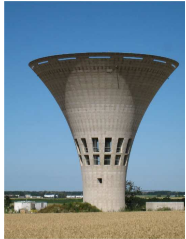
Réservoir de l'Oseraie Osny (2 x 2500m 3 )
