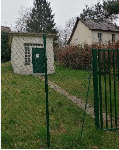
Réservoir Relais de Boisemont 120 m 3
