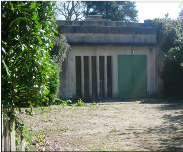
Réservoir de Boisemont 2 x 2000 m 3
