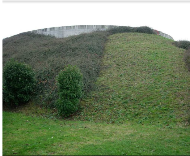
Réservoir du Bois d'Aton à Courdimanche 2500 m 3
