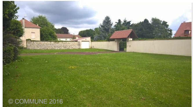
Figure 23 : Ancienne entrée vers la ferme fortifiée
