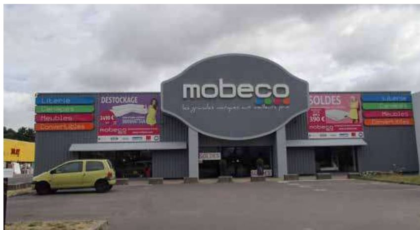
ENSEIGNE EN FAÇADE DÉPASSANT DU MUR
