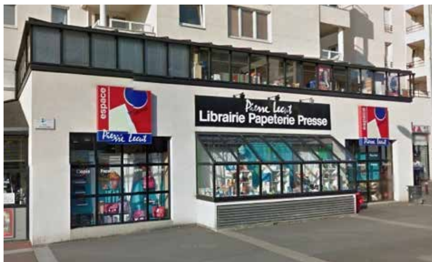
BONNE INTÉGRATION - ERMONT
