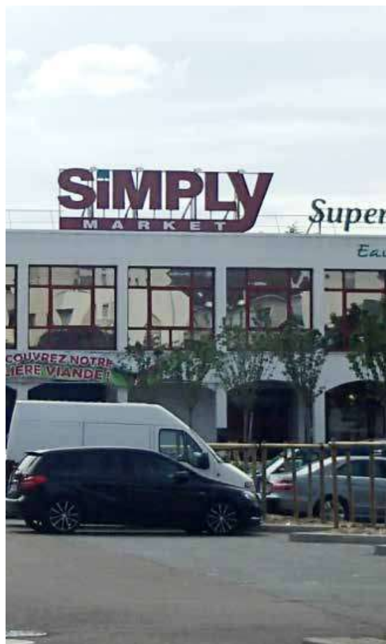
LES ENSEIGNES EN TOITURE
