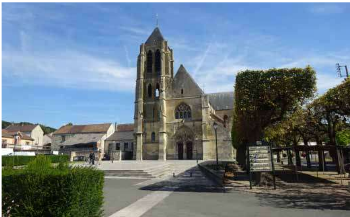
EGLISE DE BESSANCOURT
