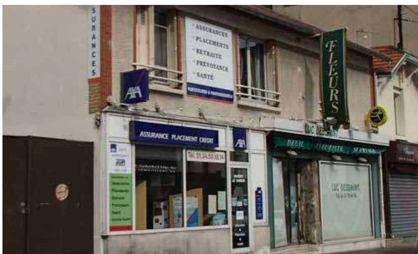
ENSEIGNES SANS LIEN AVEC LES FAÇADES - CORMEILLES-EN-PARISIS
