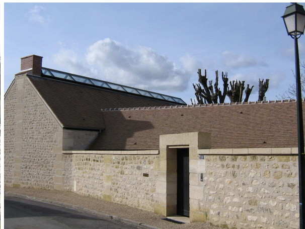
Une dynamique de rénovation qui permet de maintenir une qualité du bâti et joue parfois en faveur d'une densification du tissu ancien
