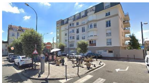
Collectif récent dans le cadre d'opération de requalification urbaine
