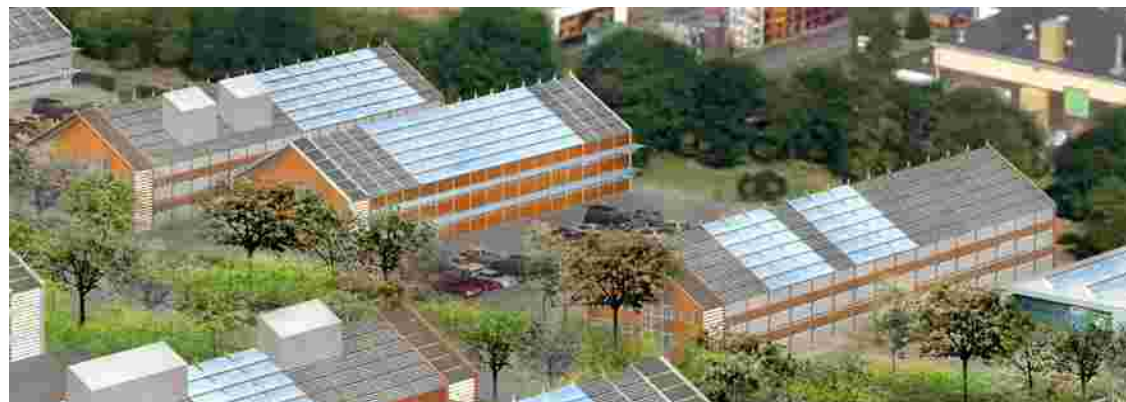
volumes bâtis dans une zone d'activités : toitures et façades aménagées en fonction de l'optimisation des apports thermiques et lumineux
