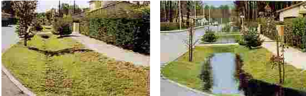
Noue en bordure de voie permettant le recueil des eaux de pluie
