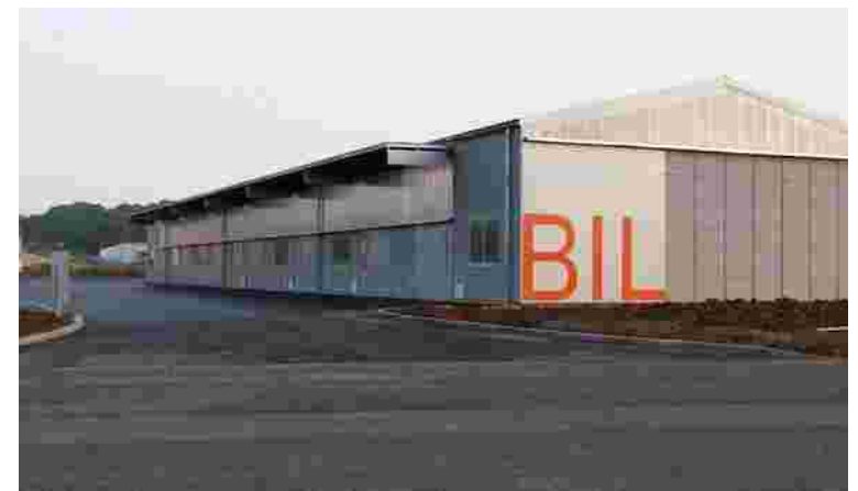
Exemple d'utilisation du bardage métallique dans un bâtiment industriel
