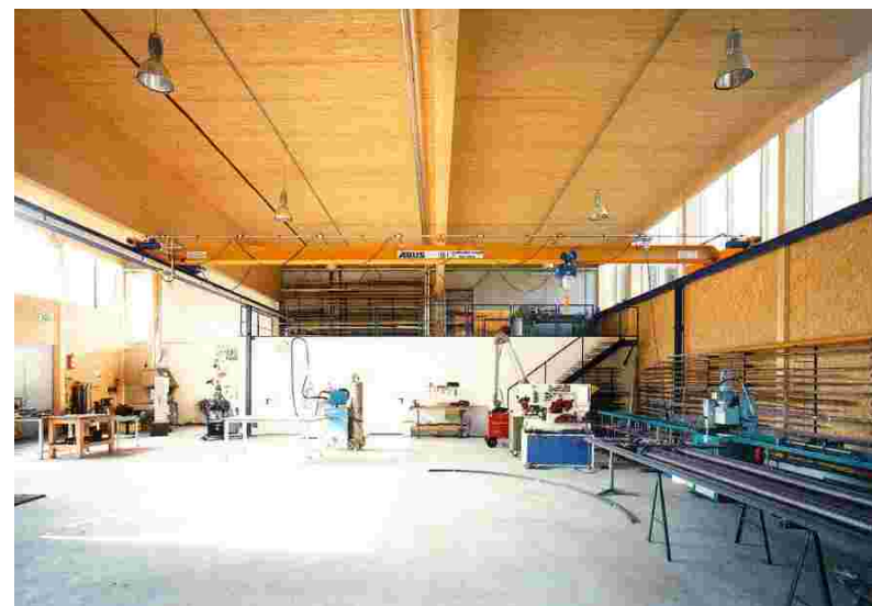
Bâtiment industriel, exemple de volumétrie intérieure et de solarisation des espaces intérieurs
