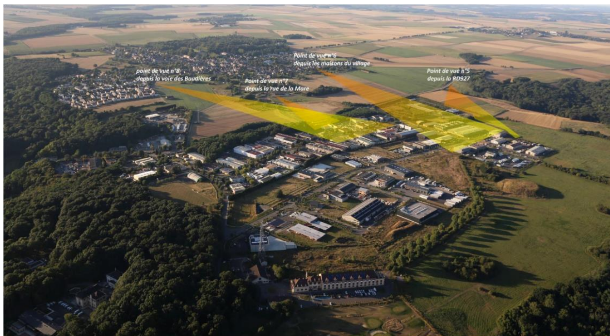
Localisation des trois points de vue principaux sur la zone d'activités / D'après photo aérienne de Mathieu Laurent
