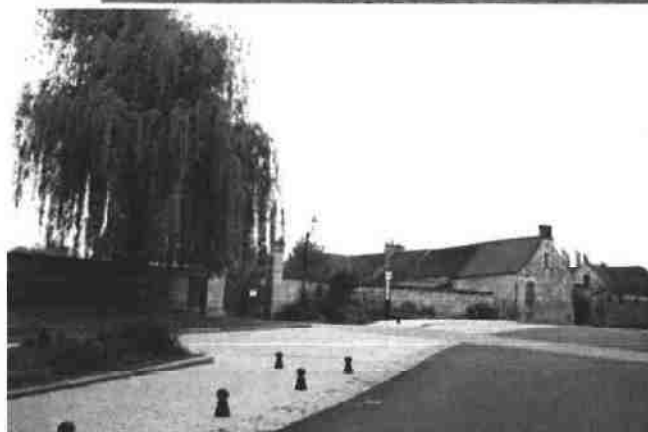
Entrée nord – rue de la Libération
