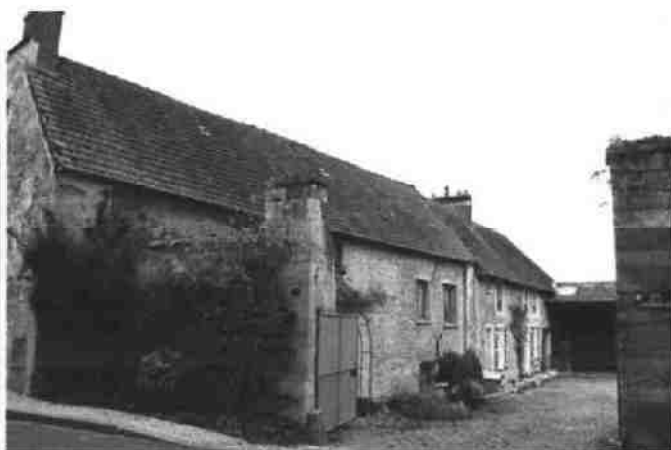
Corps de ferme dans le village
