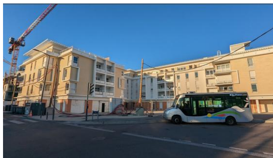
Nouveaux logements, emplacement parking rue de Nancy
