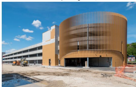
Nouveau parking relais, en construction
