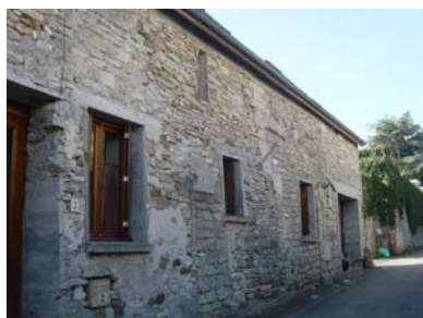
Maison rurale, rue du Logis : Ouverture récente des façades sur la rue
