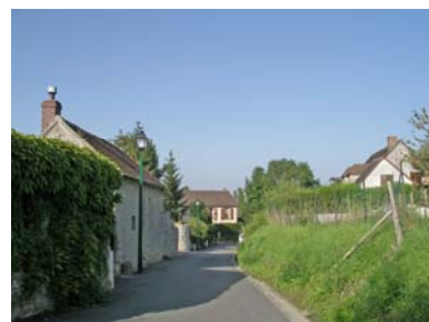
Constructions récentes Rue du Calvaire
