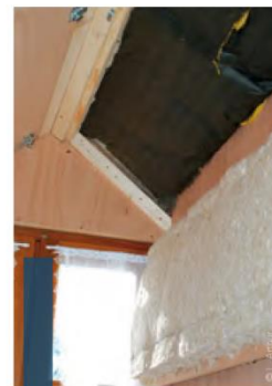
Construction d'un caisson isolé
