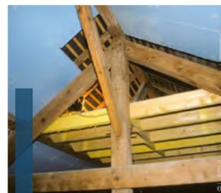
Installation d'un plancher
