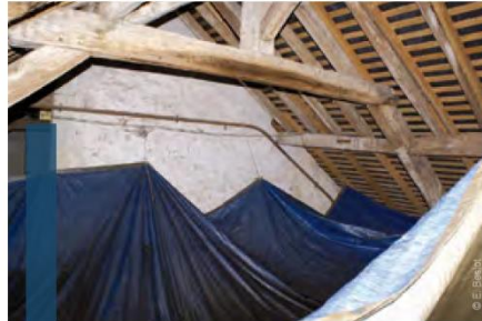
Bâches de protection dans un comble
