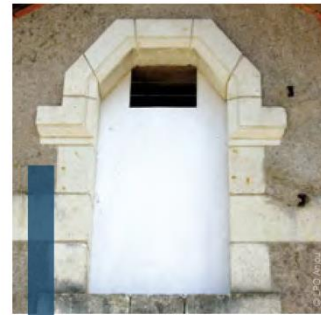
Aménagement d'une porte Création d'une ouverture en haut de la porte.
