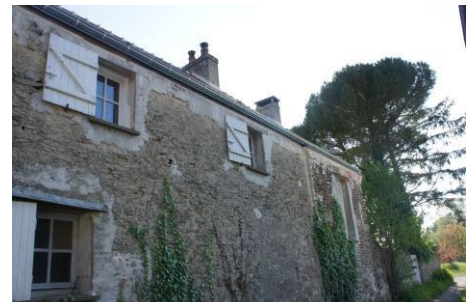
Façade sente des Maréchets
