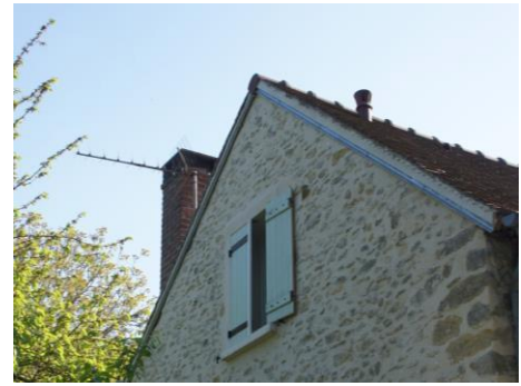
Cheminée recouverte d'une dalle béton
