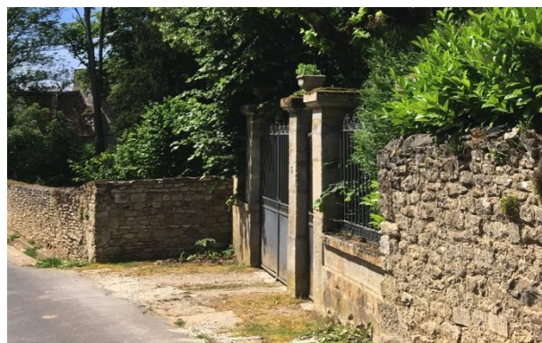
Emprise disponible pour une végétalisation en bordure de voirie
