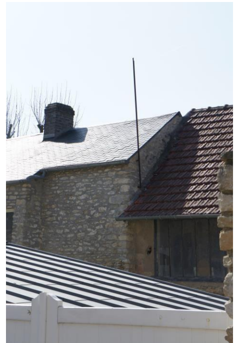
Maçonnerie beurrée à l'enduit ciment
