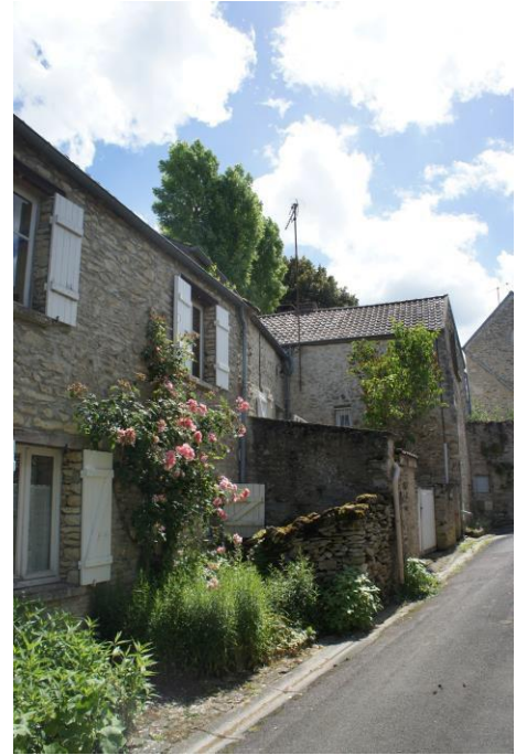
Pied de façade végétalisé
