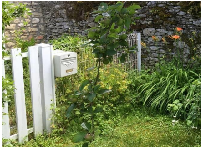
Détail de la seule clôture présente sur site
