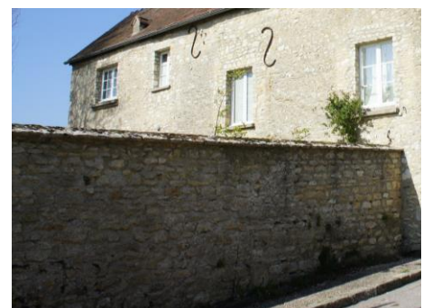
Mur de clôture (2)
