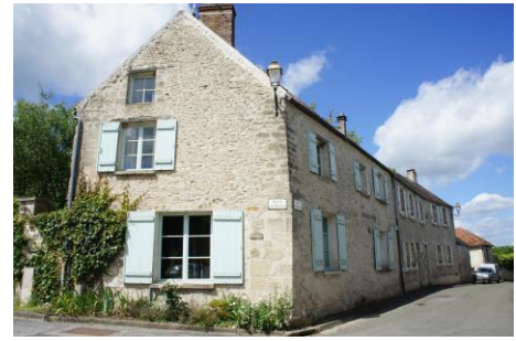
Bâtiment 1 – Angle chemin de la corniche / rue Cabarets
