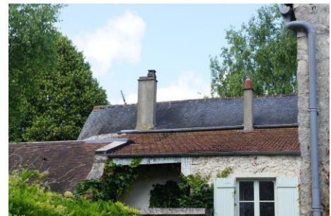
Conduit de cheminée (bâtiment 2)
