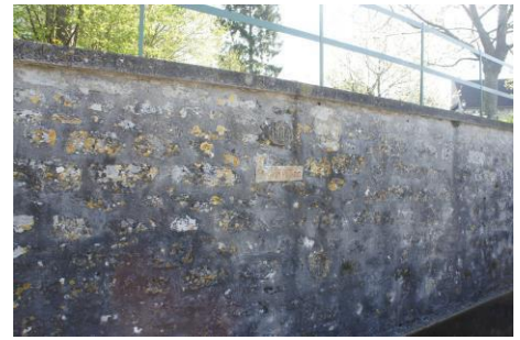
Mur de soutènement entre le verger et l'abreuvoir
