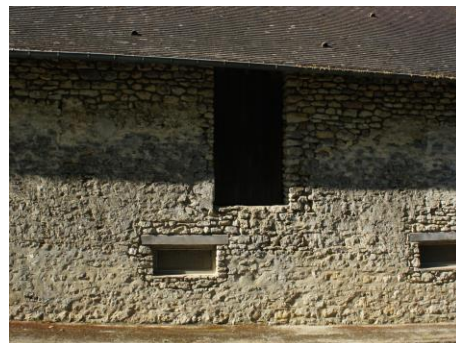
Maçonnerie sur bâtiment (3)
