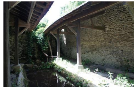
Intérieur du lavoir
