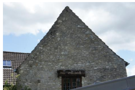
Beurrage des maçonneries à l'enduit ciment
