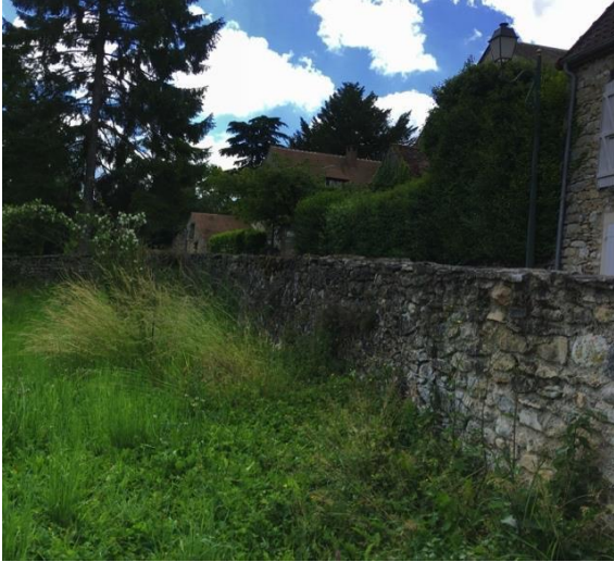
Mur de pierre rue à Moineaux
