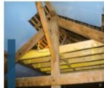
Installation d'un plancher
