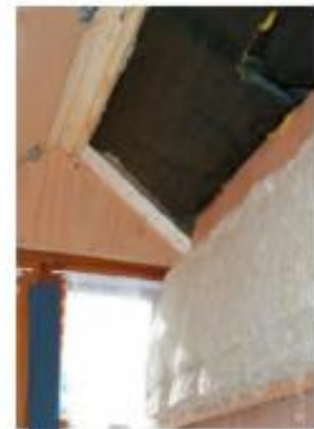
Construction d'un caisson isolé
