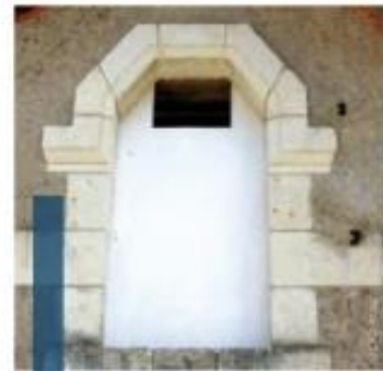
Aménagement d'une porte Création d'une ouverture en haut de la porte.
