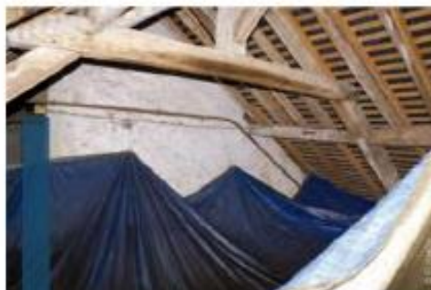
Bâches de protection dans un comble
