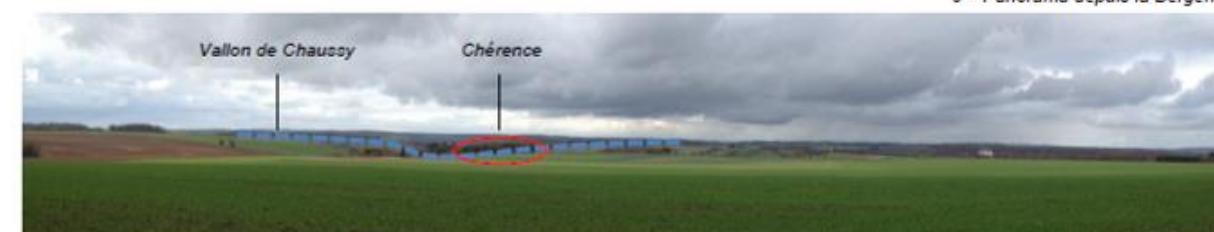
7 - Panorama depuis les espaces agricoles du « Chaud Soleil »
