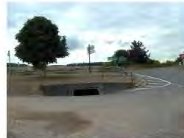
Passage de la D983 au dessus du ru du Lavoir.
