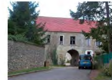
Accès à l'ancienne ferme par l'impasse Saint-Benoît.
