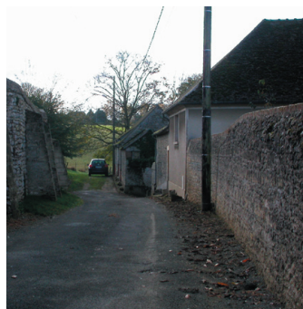
Murs traditionnels impasse de Riancourt
