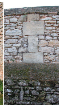
Détail du mur
