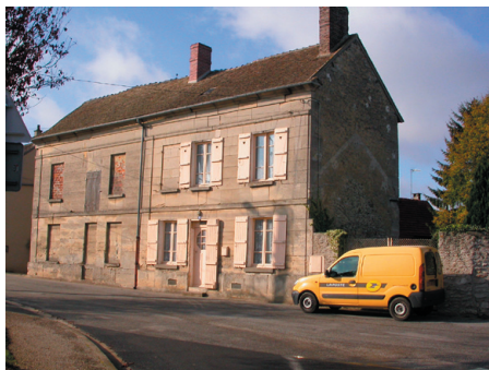
Construction rue des Tilleuls
